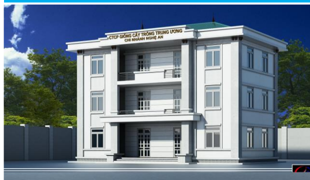
Nhà điều hành CN Vinh
